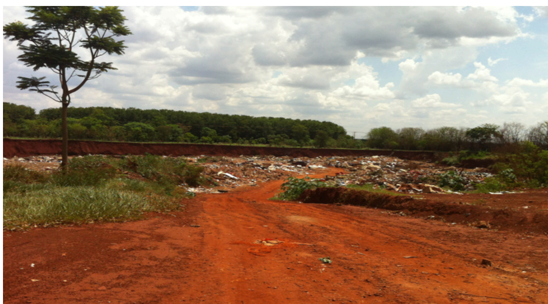
Figura 11: Disposição dos rscc na área escavada
