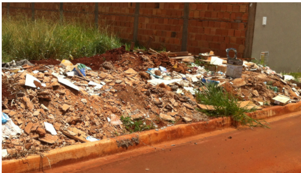
Figura 7: rscs sendo depositados inadequadamente em terrenos vazios próximos a obra ou empreendimento
